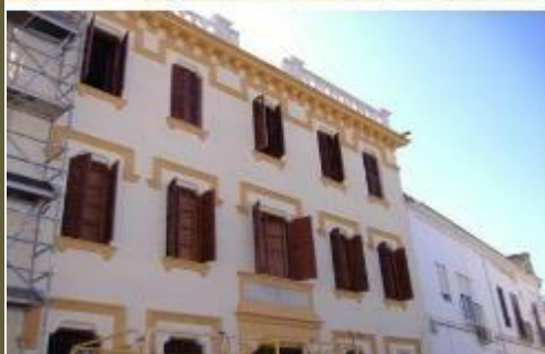
Restauración carpinterías Colegio de las Monjas. Ribarroja del Turia (2009)
